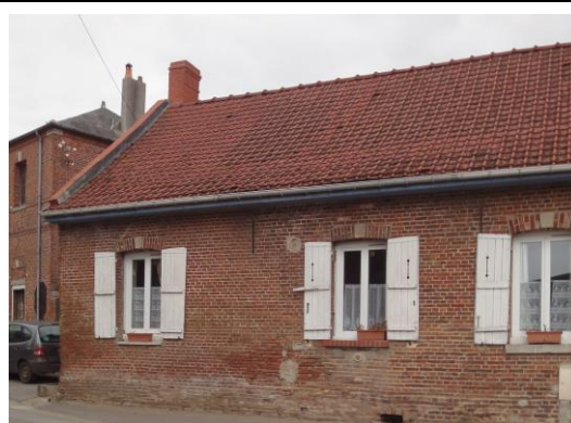
Impasse de l'église Fenêtre plus haute que large Pas de division en carreaux par ouvrant Volets en bois à 3 barres Linteaux en briques avec clef en pierre légèrement cintrés
