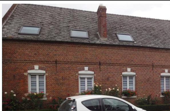
Impasse de l'église Fenêtre plus haute que large Division en 3 carreaux par ouvrant Coffre de volets roulants visibles sans maintien de volets Linteaux en briques avec clef en pierre légèrement cintrés
