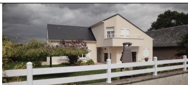
Rue de la place Construction couverte en ardoise avec une forme plus diversifiée Coloris dans les tons pierre et blanc Balcon Volets roulants Présence de baies vitrées
