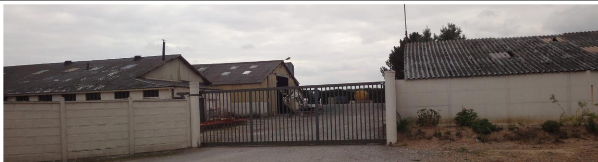
Rue de thieux Exploitation H
