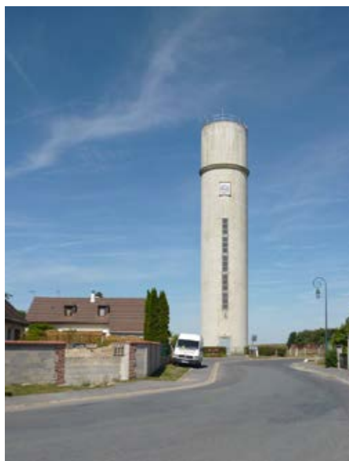
Château d'eau de Brunvillers-la-Motte.
