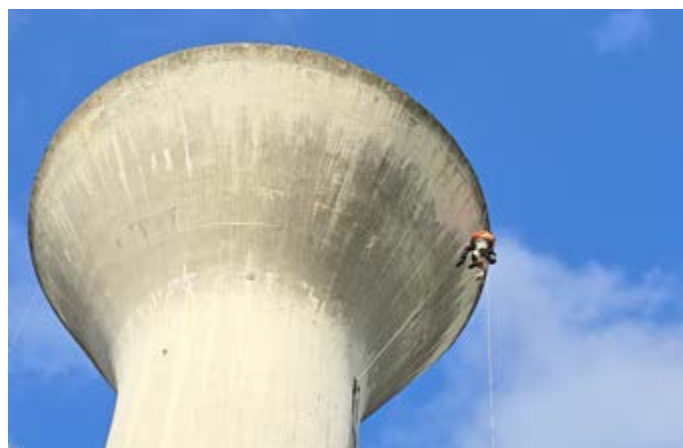
Réalisation du diagnostic béton sur le château d'eau de Moyenneville.
